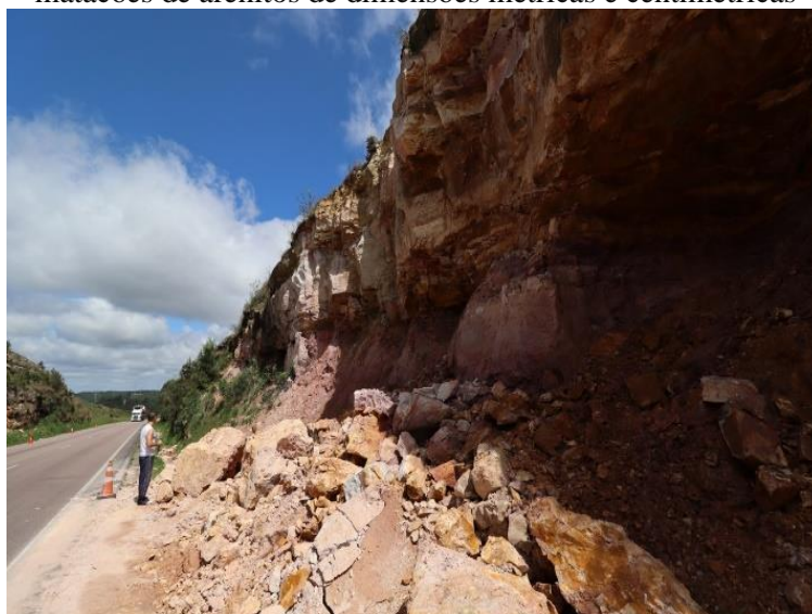
Figura 3 - Quedas de rochas registrados na margem esquerda da rodovia, evidenciando blocos e matacões de arenitos de dimensões métricas e centimétricas
